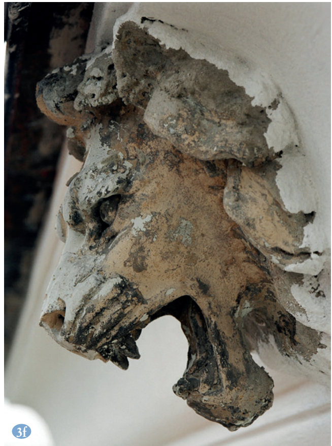
Abb. 3 (d – f): Gussornamente und Schalungsbeton des 19. Jahrhunderts aus Romanzementmörteln.
