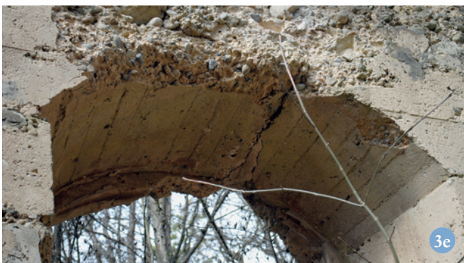
Abb. 3 (d – f): Gussornamente und Schalungsbeton des 19. Jahrhunderts aus Romanzementmörteln.
