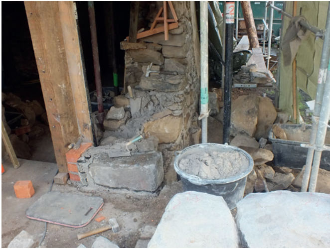
Abb. 5 (links) und 6 (rechts): Innerhalb eines Tages lässt sich eine raumhohe Natursteinmauer durch die Verwendung von Heißkalkmörtel ohne Wartezeiten fertigstellen.
