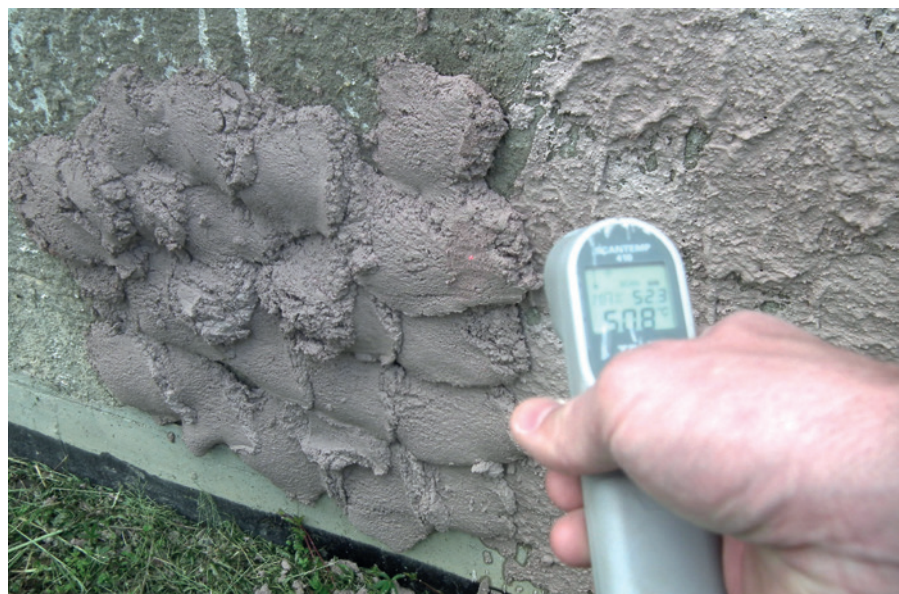
Abb. 3: Temperaturmessung an der Oberfläche des an die Wand angeworfenen Heißkalkmörtels: bis 52° C.
