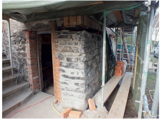
Abb. 5 (links) und 6 (rechts): Innerhalb eines Tages lässt sich eine raumhohe Natursteinmauer durch die Verwendung von Heißkalkmörtel ohne Wartezeiten fertigstellen.
