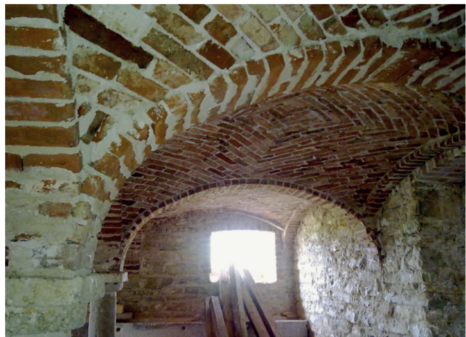
Abb. 7: Freibändiges Mauern von Gewölbekappen mit Heißkalkmörtel ohne Lehrgerüst.
