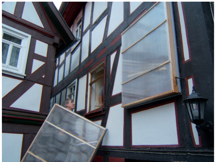
Abb. 3: Entfernung der Baufenster nach Instandsetzung der Fensterflügel in der Werkstatt.
