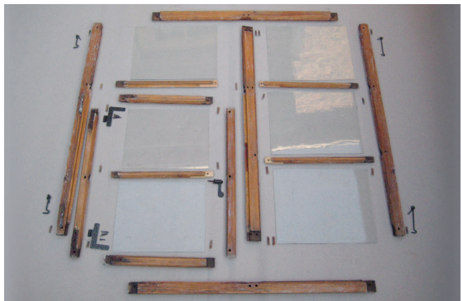
Abb. 6: Reparaturfreundliche Bauweise: Fenster mit Glasnut, Eckverbindungen verzapft und mit Holznägeln befestigt.
