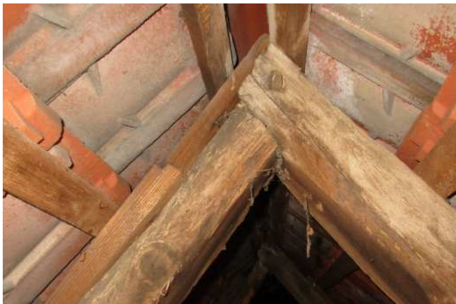
Abbildung 4 Scherzapfenverbindung am Sparrenfirst.
