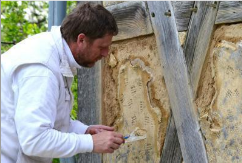
Erhalt von originalen Putzbeständen durch den Einsatz traditioneller Materialien und Handwerkstechniken
